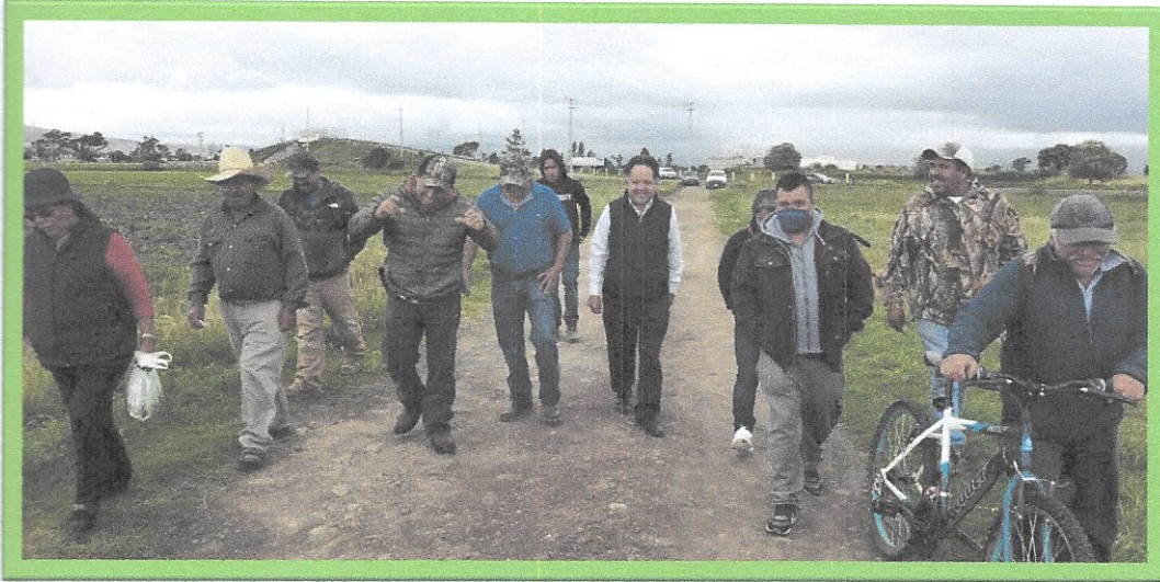
Recorrido con vecinos de la colonia Las Animas y presa San Luis del Ejido de Huapalcalco para llevar a cabo los trabajos de Electrificación.
