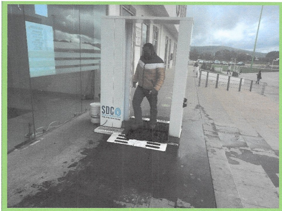
Instalación de Arco Sanitizante en la entrada de la Presidencia Municipal para Protección de ciudadanos y el personal que labora.
